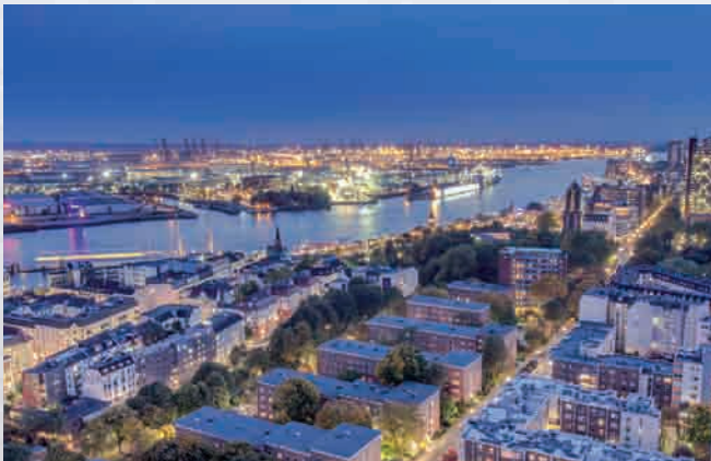
Hafenstadt Hamburg Port city of Hamburg
